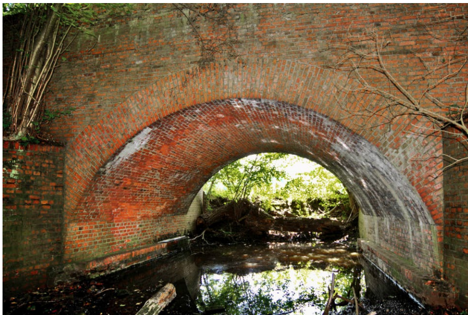
Most w Więclawiu, fot. M. Schiller, 2025
